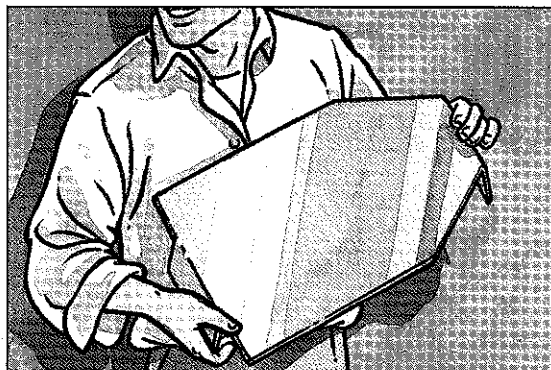
La base di appoggio di ogni condotto secondario è una piastra intermedia in acciaio inox di 4 mm, che Arturo posiziona sopra il raccordo al condotto principale del secondario precedente, per attribuire alla canna sovrastante la capacità di portare il peso proprio.
