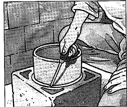
I cordoli devono essere interposti tra camicie e Refrattario ogni due elementi: Arturo li posiziona man mano che il camino sale: il cordolo sempre per ultimo, dopo la camicia e il Refrattario, forzato fino a circa metà dell'elemento.
